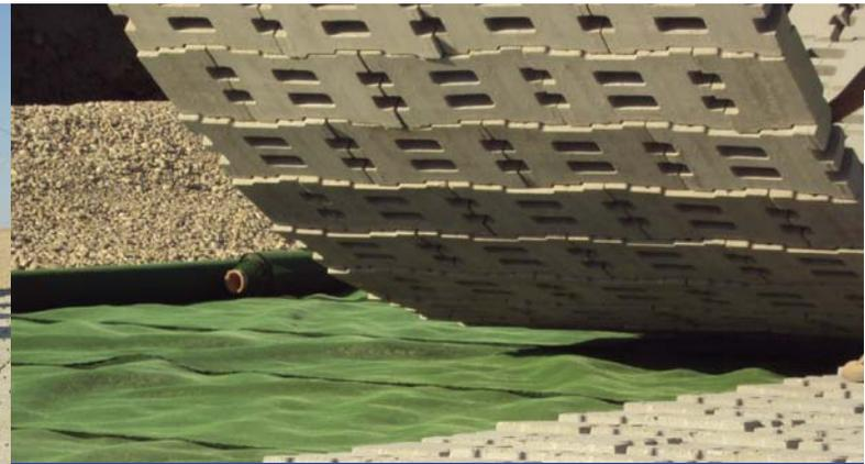
Solución flexible de bloques de hormigón de tamaño uniforme atados en sentido longitudinal con cables para un fácil manejo y rápida instalación.
